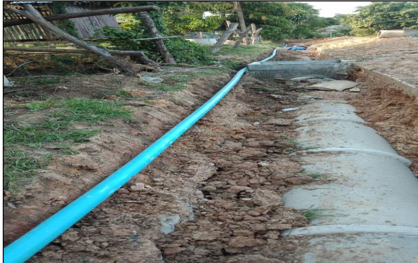
โครงการวางท่อระบายน้ำ พร้อมบ่อพัก หมู่ที่ ๔ เส้นคุ้มบ้านน้อยหนองกอง
